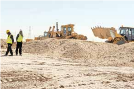
أعمال تجهيز الأرض لمشروع المطلاع
